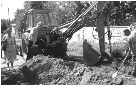
Йдуть роботи з проведення каналізації
